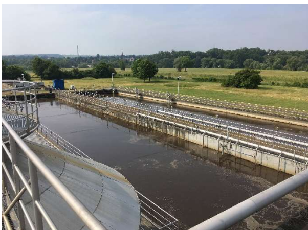
Abbildung 1: Ansicht Denitrifikationsbecken 2
