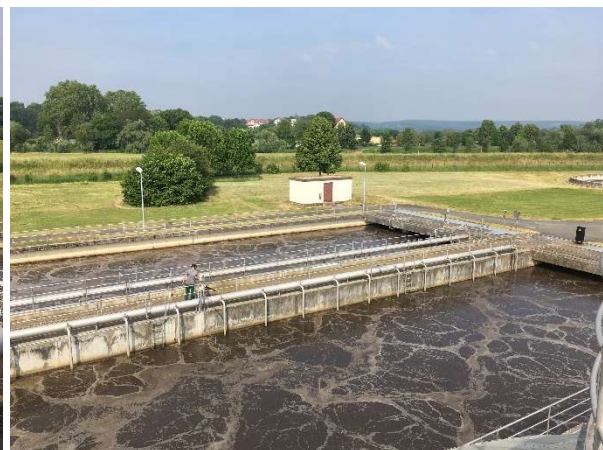
Abbildung 2: Ansicht Nitrifikationsbecken 2
