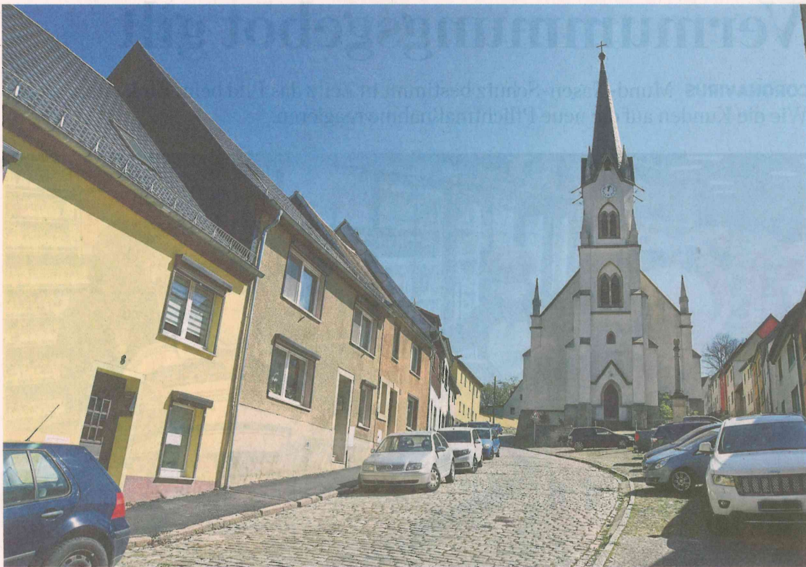
Am Montag starten offiziell die Bauarbeiten am Osterfelder Kirchberg. Neben dem Kanalbau wird auch die Straße neu gestaltet. Vor der Lutherkirche wurden die Bäume bereits gefällt.
