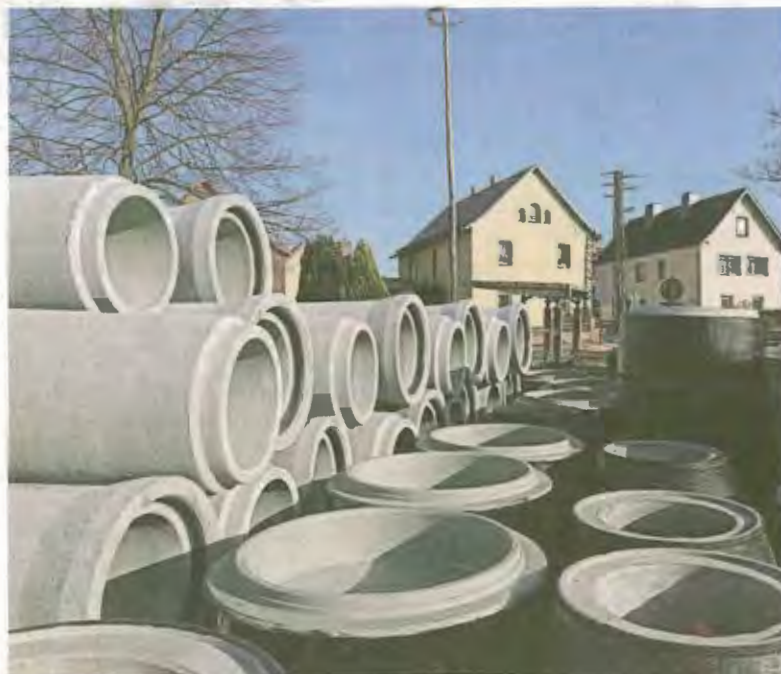
Im Osterfelder Ortsteil Haardorf begannen 2018 Kanalbauarbeiten. Im vergangenen Jahr wurde das neue Abwassernetz fertig.
